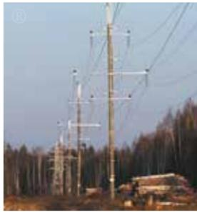
Рис. 2. Опоры СПБ110-4 на ВЛ 110 кВ
