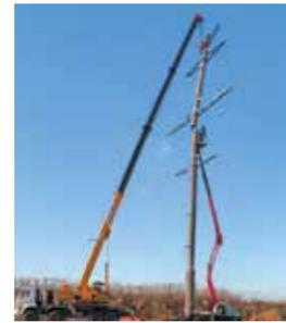
Рис. 4. Монтаж верхней секции опоры СПБ220-4ФТ на ВЛ 220 кВ
