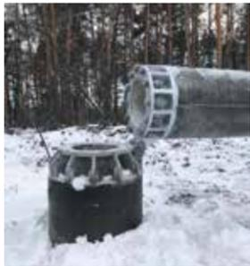
Рис. 1. Узел соединения стойки опоры 2СПБ500-3В с фундаментом
