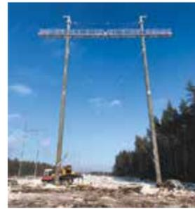
Рис. 3. Опора 2 СПБ500-3В на ВЛ 500 кВ
